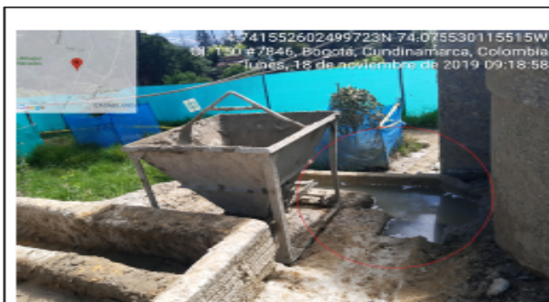
Fotografía 3. Sedimentador receptor la mezcla de cemento. Fuente: SCASP Grupo RCD – noviembre 2019.
